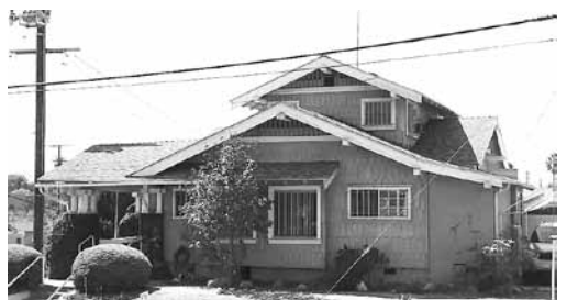
(写真)屋根葺替をしたハリウッド教会外観
